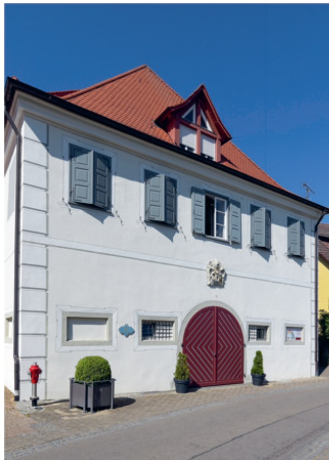
Abb. 8: Irseer Hof in Hagnau, Ansicht von Südwesten.
